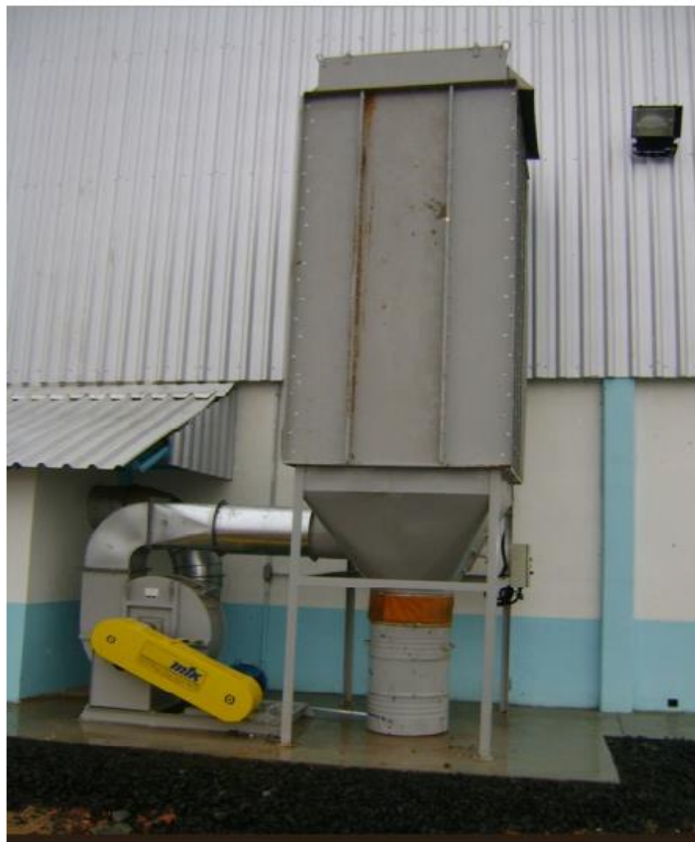
Figura 12: Instalação de um filtro de manga
