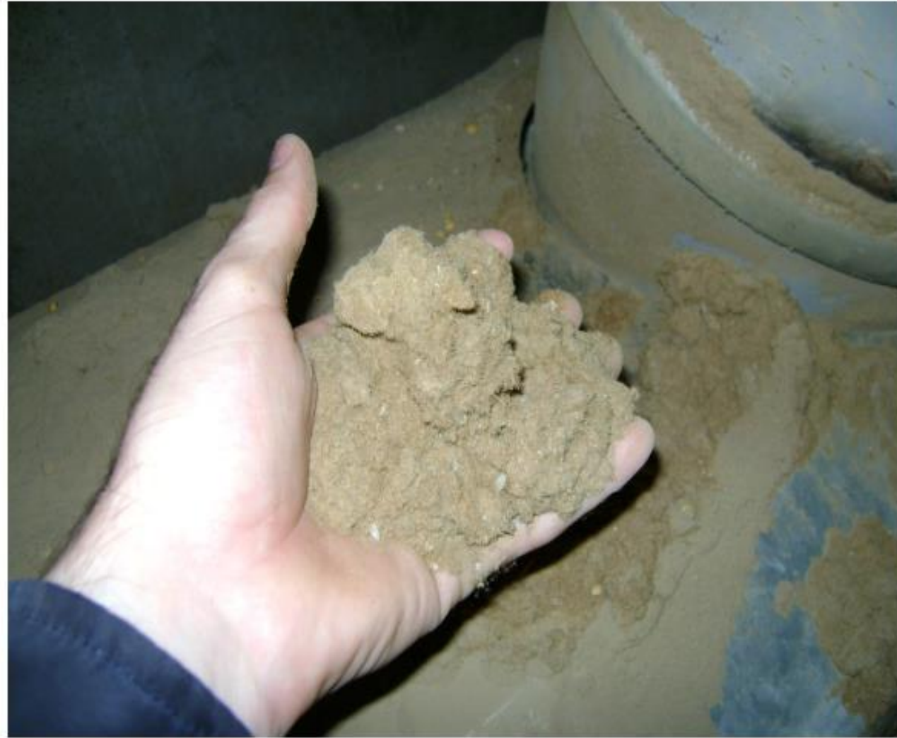
Figura 32: Acúmulo de pó na fita transportadora localizada no túnel subterrâneo
